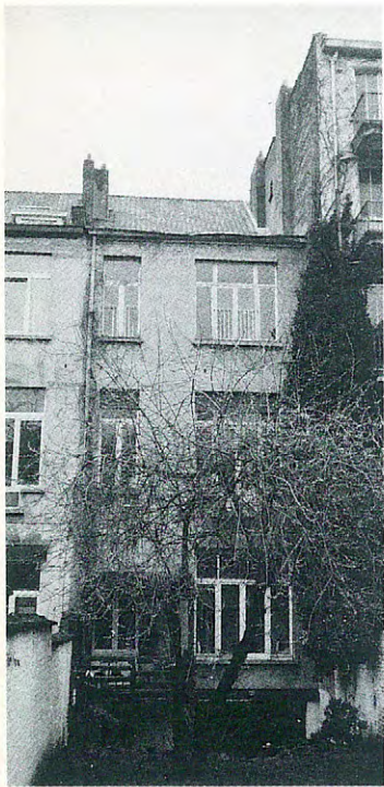
Façade arrière avant travaux
