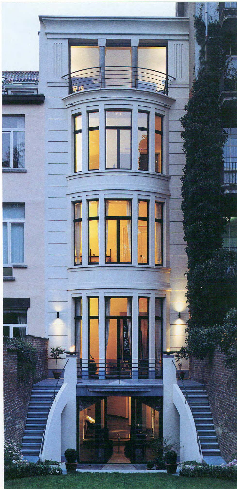
Façade arrière après travaux
