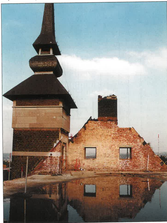
Il a plu à l'intérieur pendant des années mais le bâtiment est resté sain
